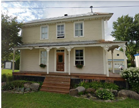
721, rue Principale (1860) Maison québécoise traditionnelle à toit à deux versants droits
