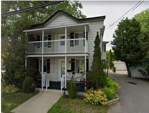
673, rue Principale (1910) Maison de style vernaculaire à toit plat
